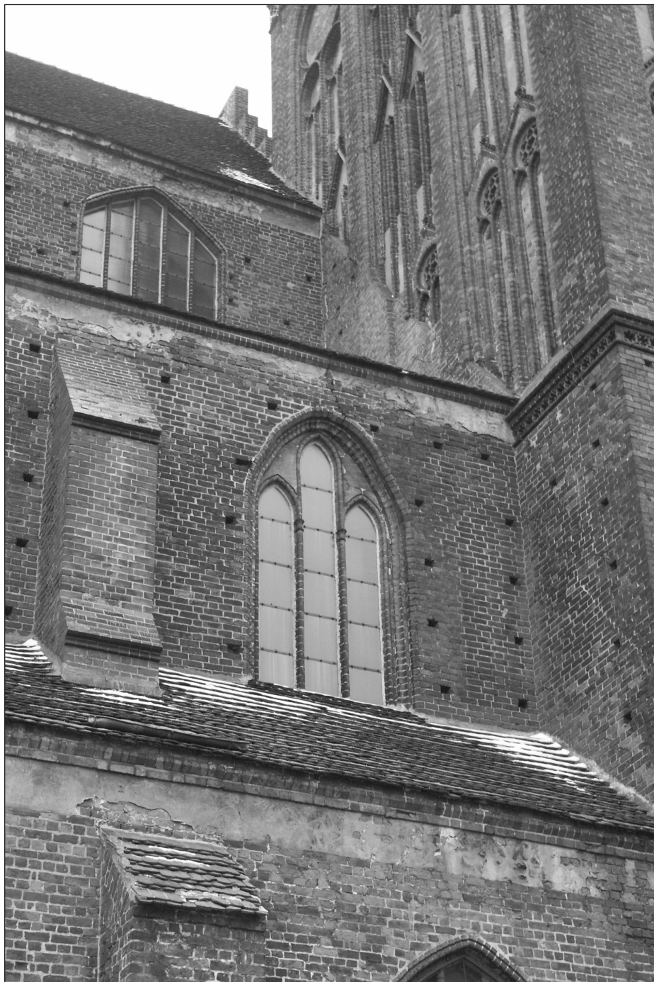
Ilustr. 9. Stargard, kościół parafialny NMP, miejsce styku korpusu nawowego z masywem wieżowym – widok od północnego wschodu, widoczny ślad po linii dachu pierwotnej hali, fot. Marek Fiedorowicz
