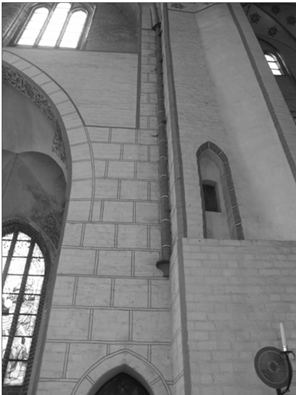
Ilustr. 6. Stargard, kościół parafialny NMP, miejsce styku północnej nawy bocznej korpusu z obejściem chóru – widok od południa, ślad po ganku obiegającym, fot. Marek Fiedorowicz
