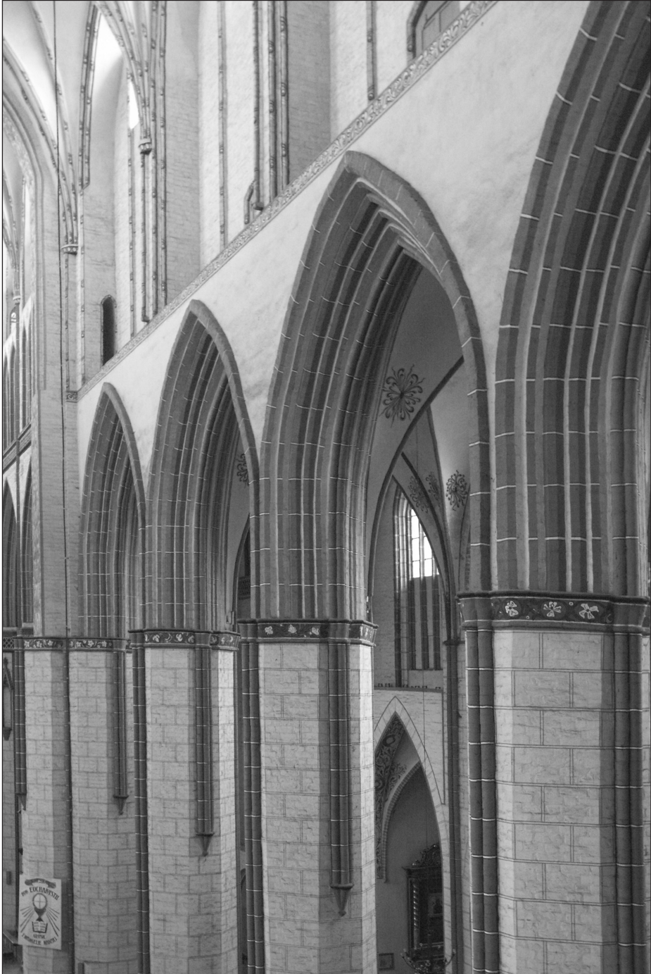
Ilustr. 3. Stargard, kościół parafialny NMP, południowy ciąg filarów międzynawowych korpusu – widok ku wschodowi, fot. Marek Fiedorowicz
